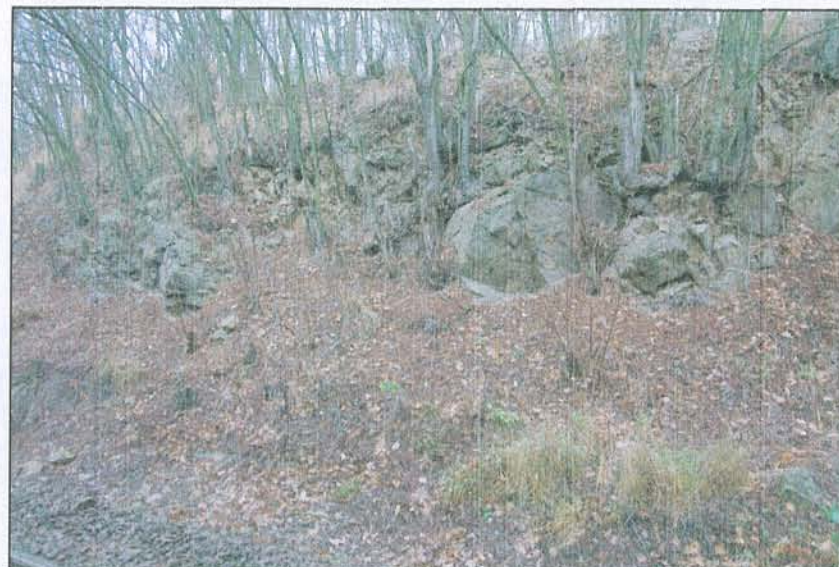
Obr. 6 Detail skalního zářezu - kořeny stromů v puklinách masívu způsobují rozvolnění skalních bloků
